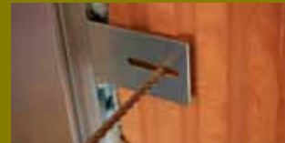
6. Türzarge in Maueröffnung einsetzen und fest verschrauben.
