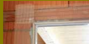
7. Putznetz einklicken und in den Ecken überlappen.
