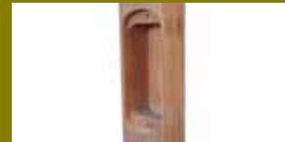
8. Ausgefräßtes Holzteil einsetzen, Scharniere fixieren und Tür einhängen.
